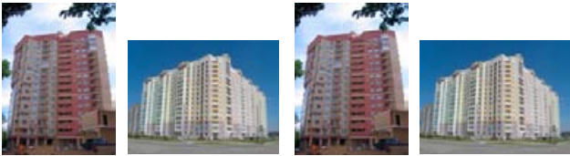
Новое строительство, октябрь 2010 г.
